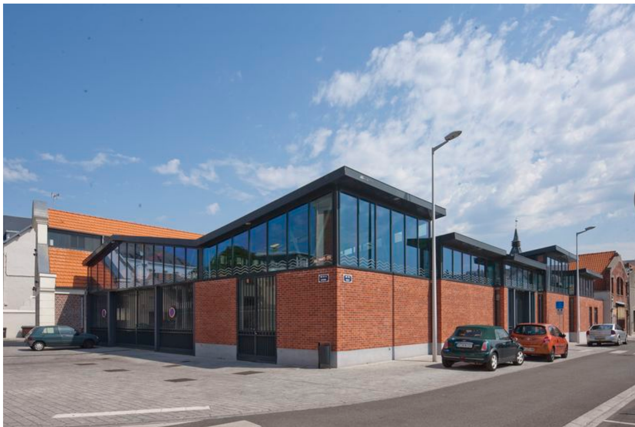
Vue générale depuis la rue des halles.
