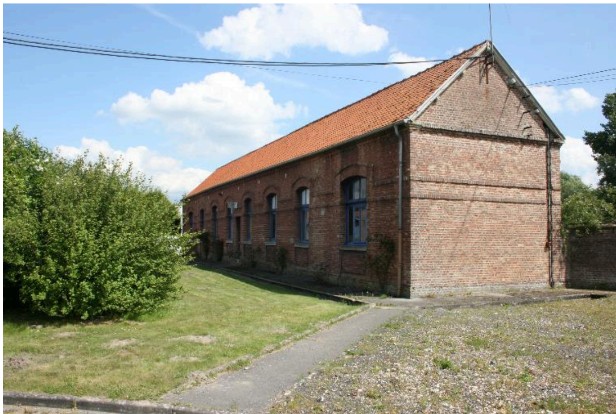
Les anciens bureaux, façade nord.
