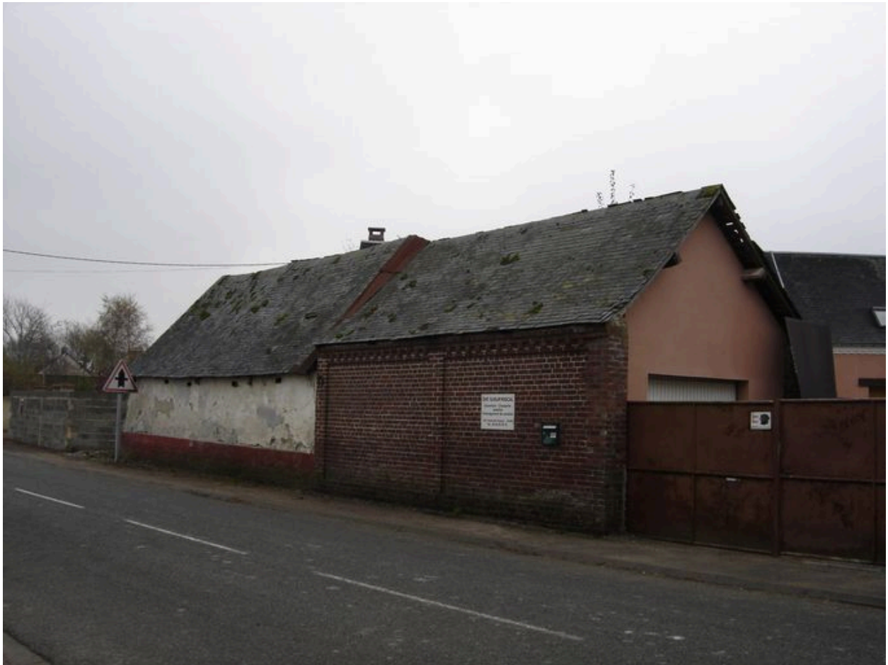
Vue des bâtiments sur rue (grange, étables).
