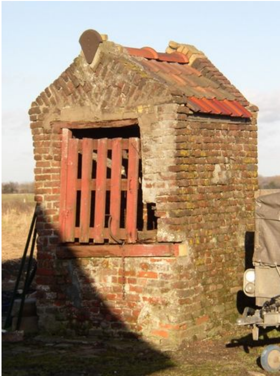
Vue générale du puits C.
