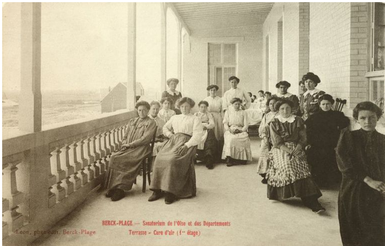
Élévation antérieure, galerie de cure du 1er étage, vue en enfilade montrant des femmes pensionnaires installées pour y effectuer leur cure d'air. Carte postale, début du 20e siècle (coll. part.).
