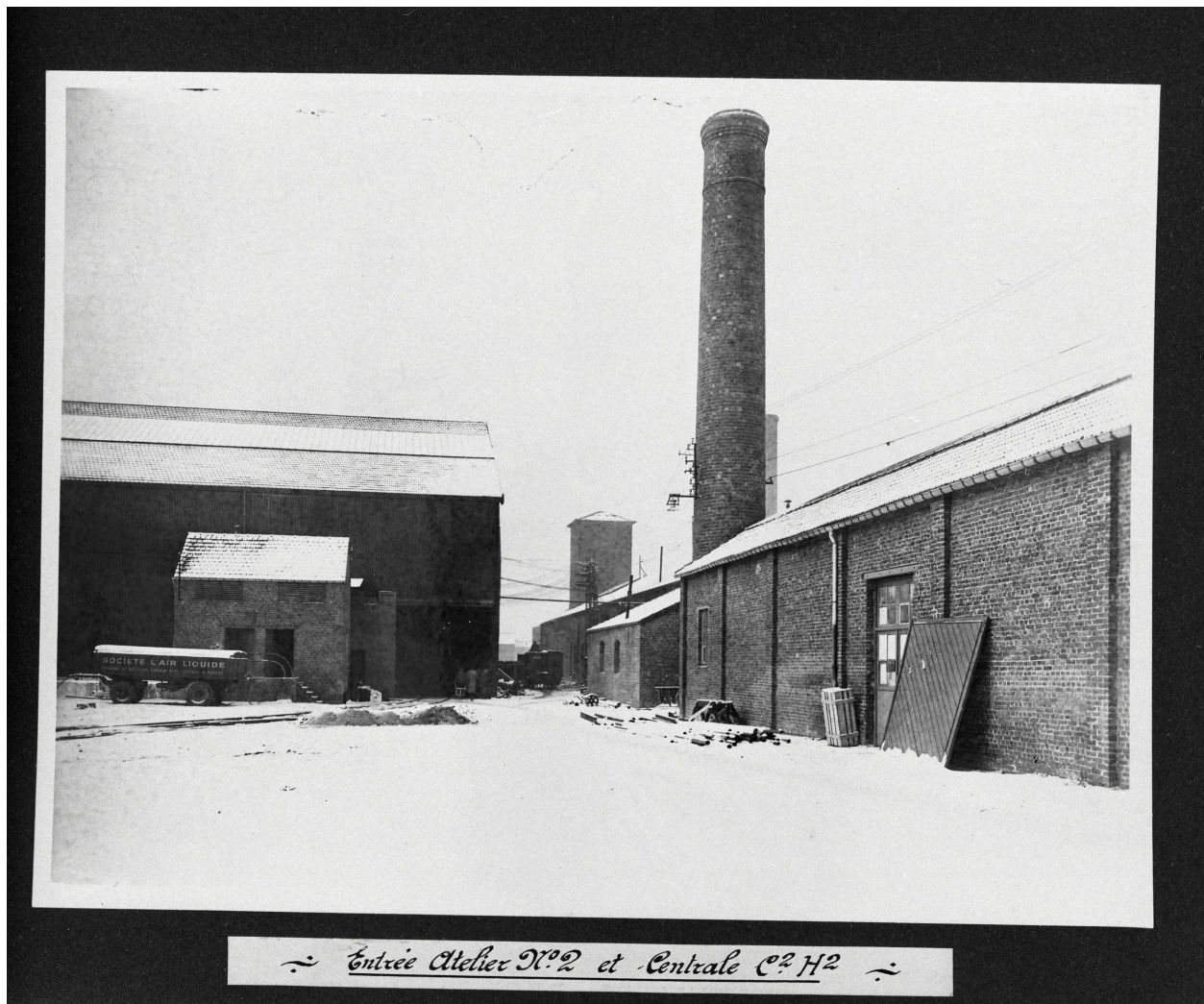
Entrée de l'atelier n° 2 et centrale de production de gaz acétylène, 16 février 1940. Photographe inconnu (coll. part., archives Cerec).
