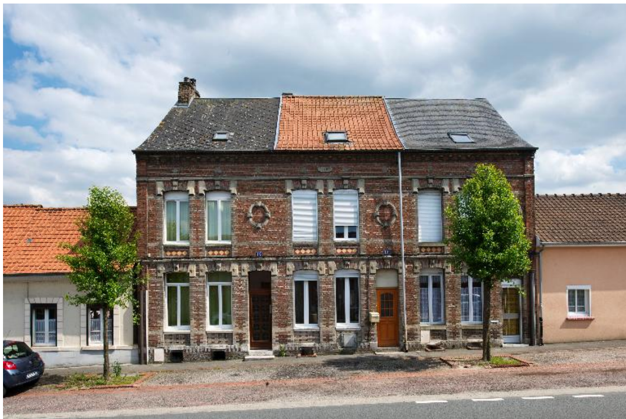
Vue d'ensemble des trois logements.
