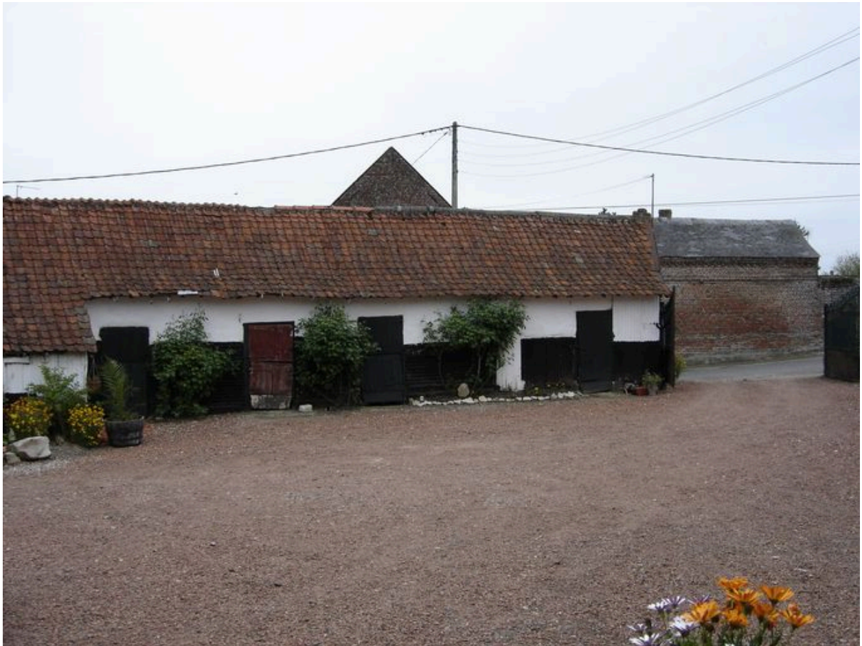
Vue des étables les plus au nord.
