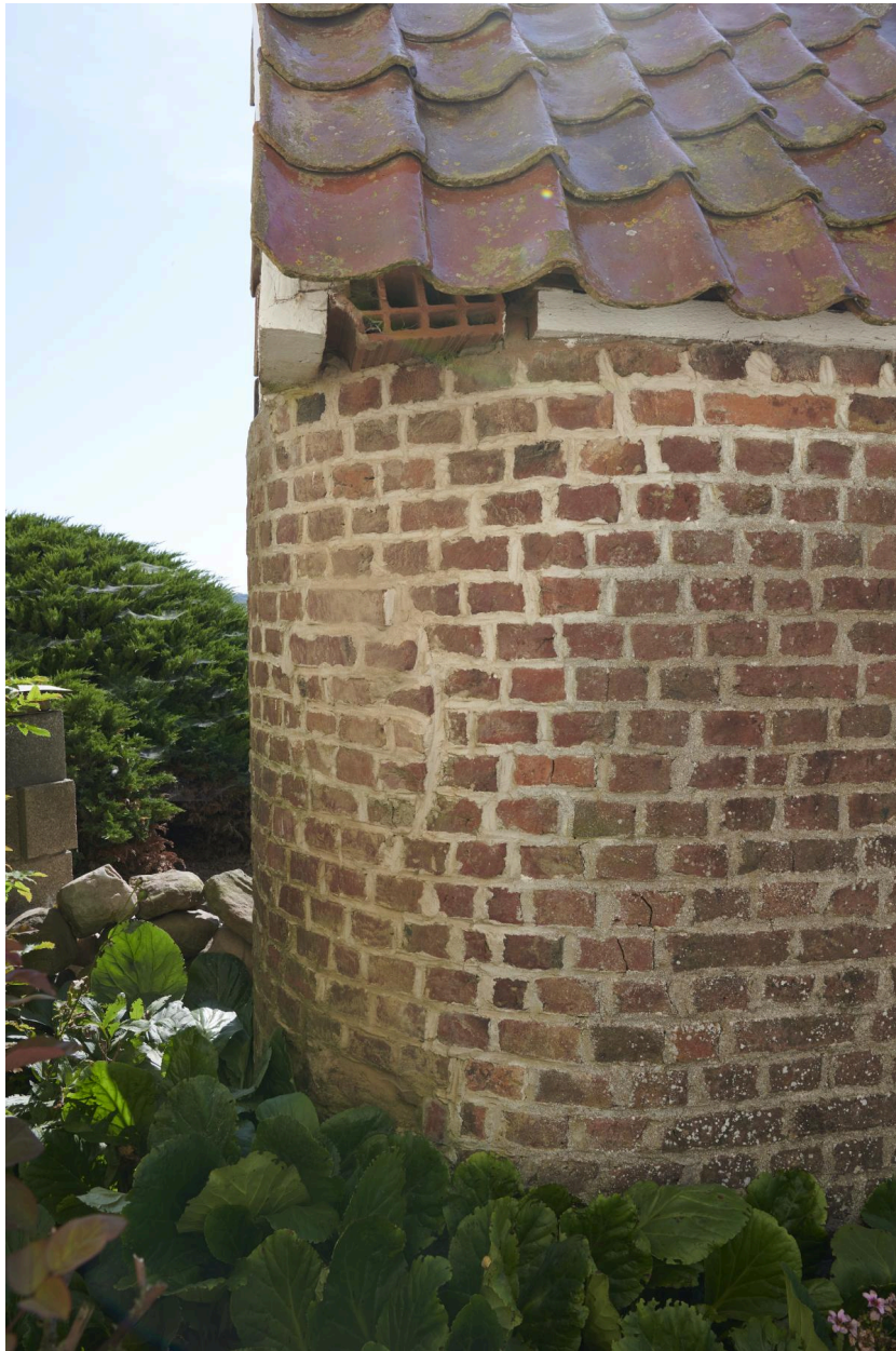
Détail de la maçonnerie "arrondie" à l'arrière de la chapelle.
