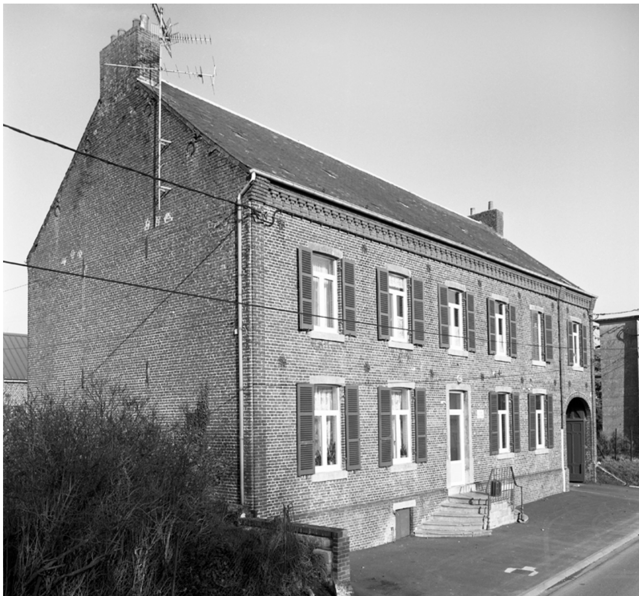
Esquéhéries, ancienne maison de notable (étudiée), 13 rue du 8-Mai.
