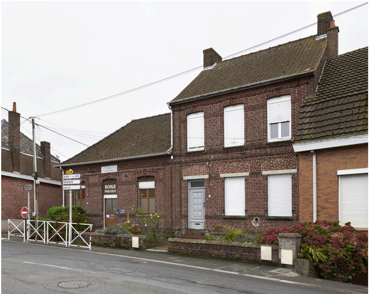
Façade sur rue, vue depuis le nord-ouest.
