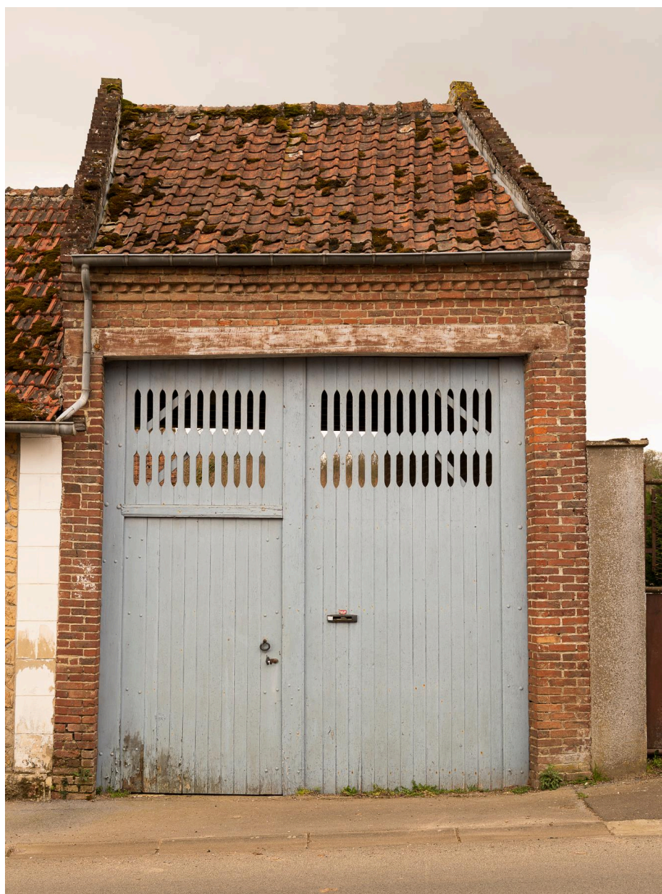
Entrée charretière, n°223 de la rue de Grandvilliers, vue prise depuis le nord.
