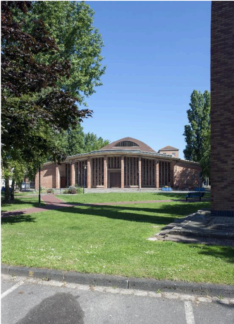
Élévation antérieure de l'église, depuis le clocher.
