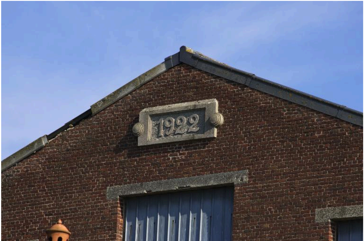
Détail de la date de 1922 en ciment moulé au sommet de l'atelier de fabrication.
