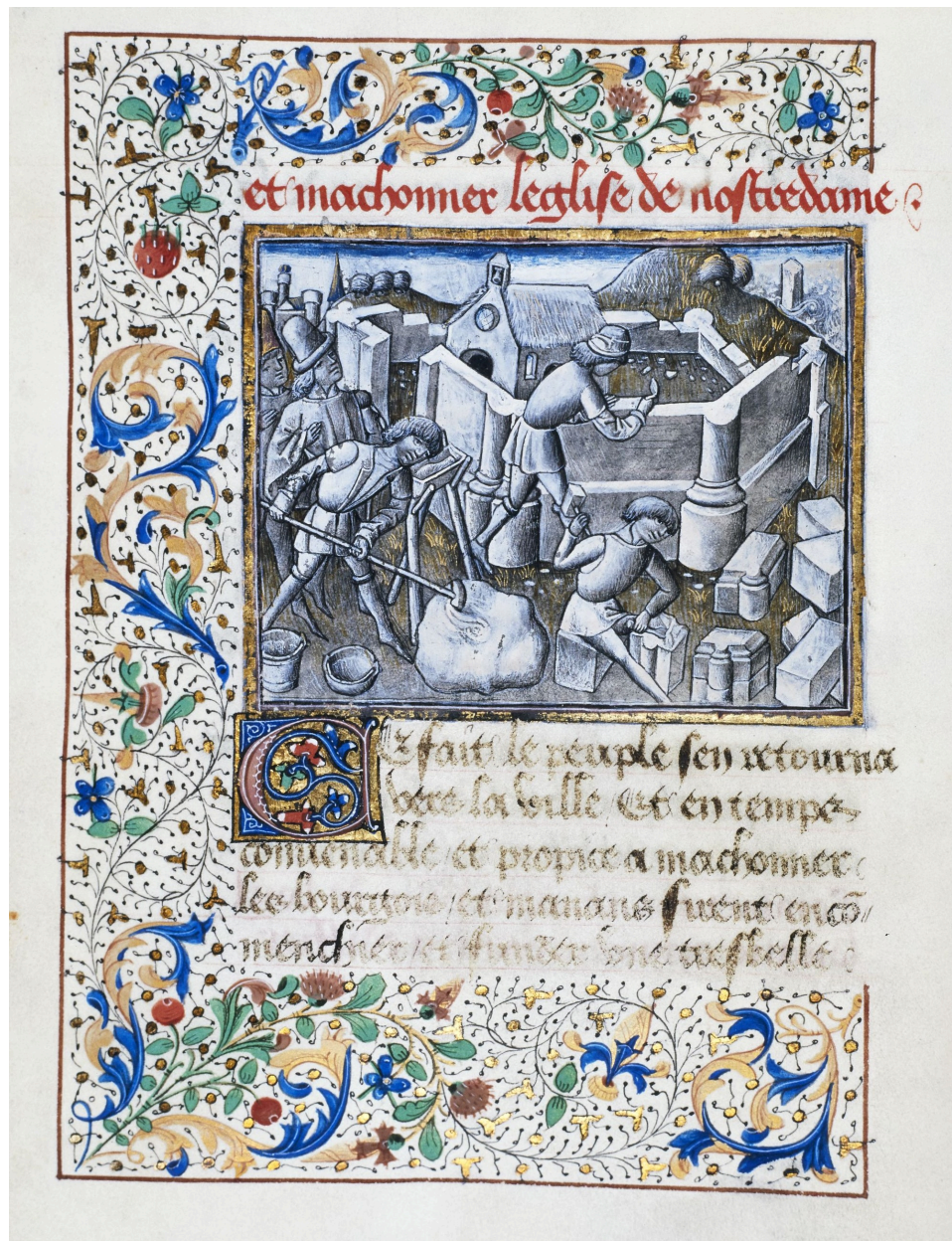
Construction des murs. B. Arsenal, manuscrit.
