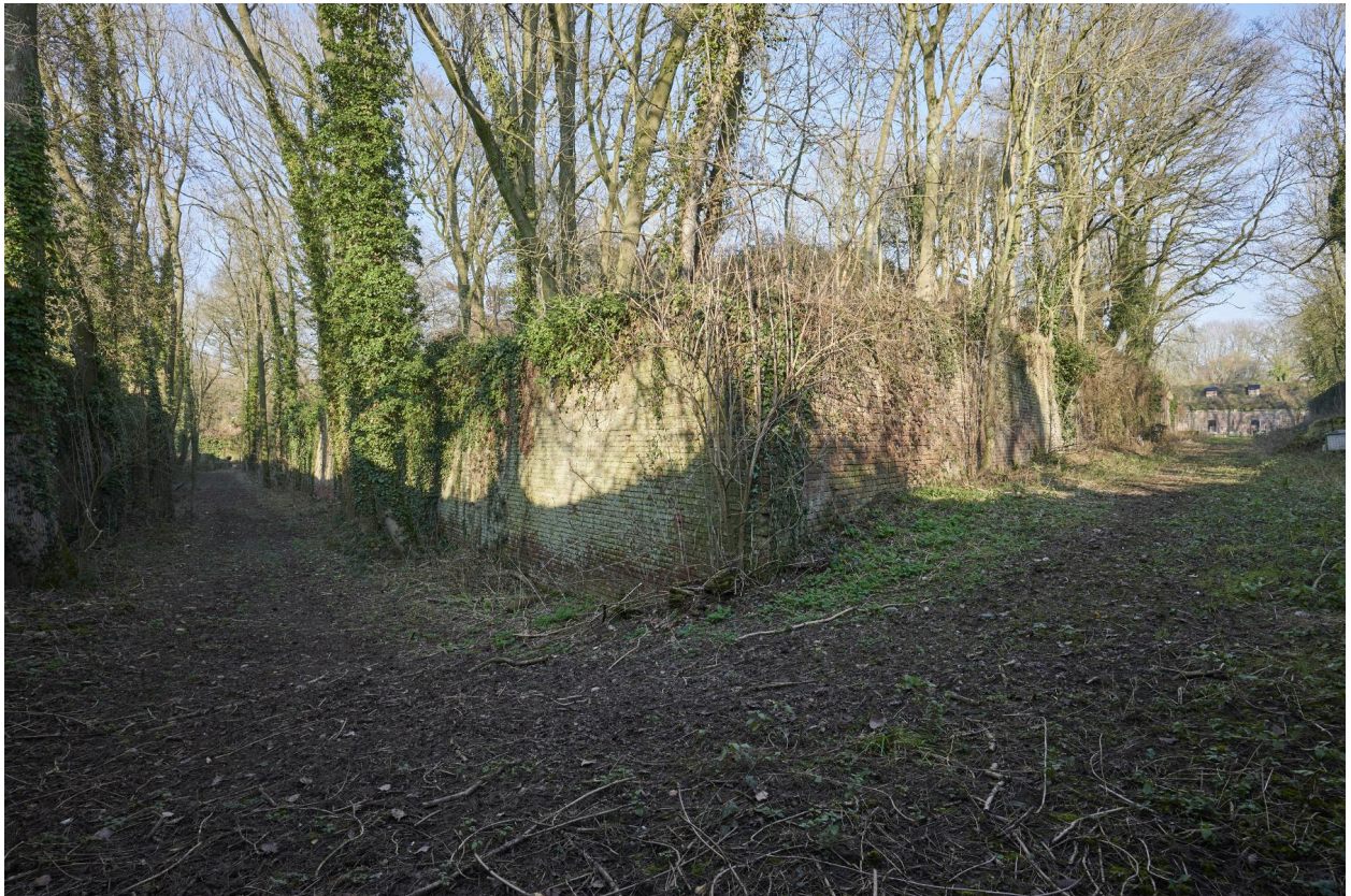
Saillant sud-est. Au fond et à droite, la caponnière double.
