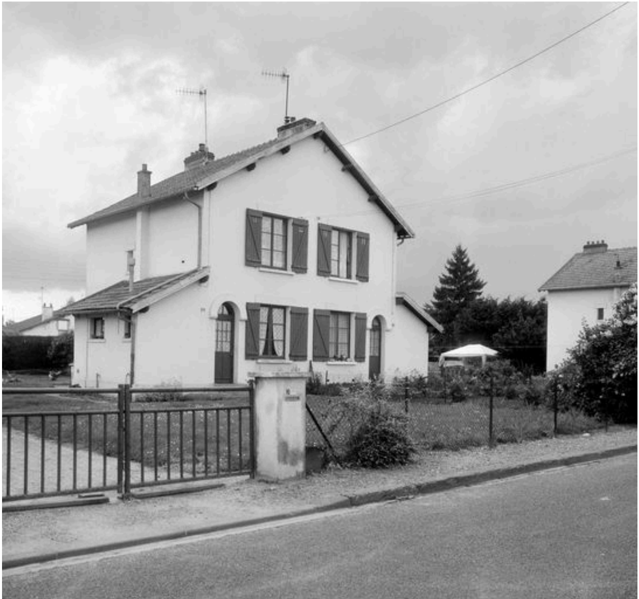
Maisons d'ouvrier en logements jumelés.
