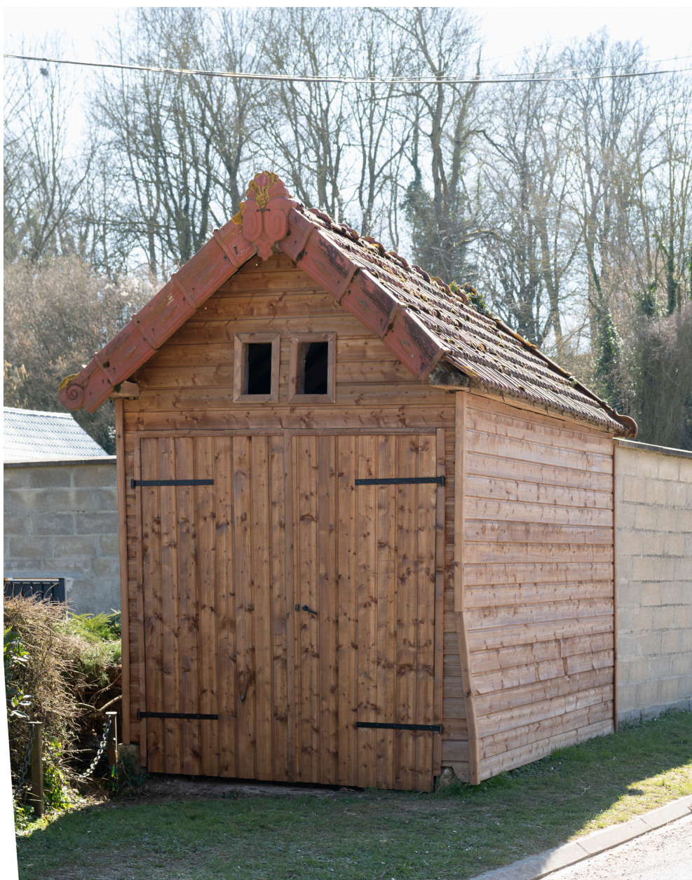
Remise de matériel d'incendie, rue la Ruellette, vue depuis le nord.
