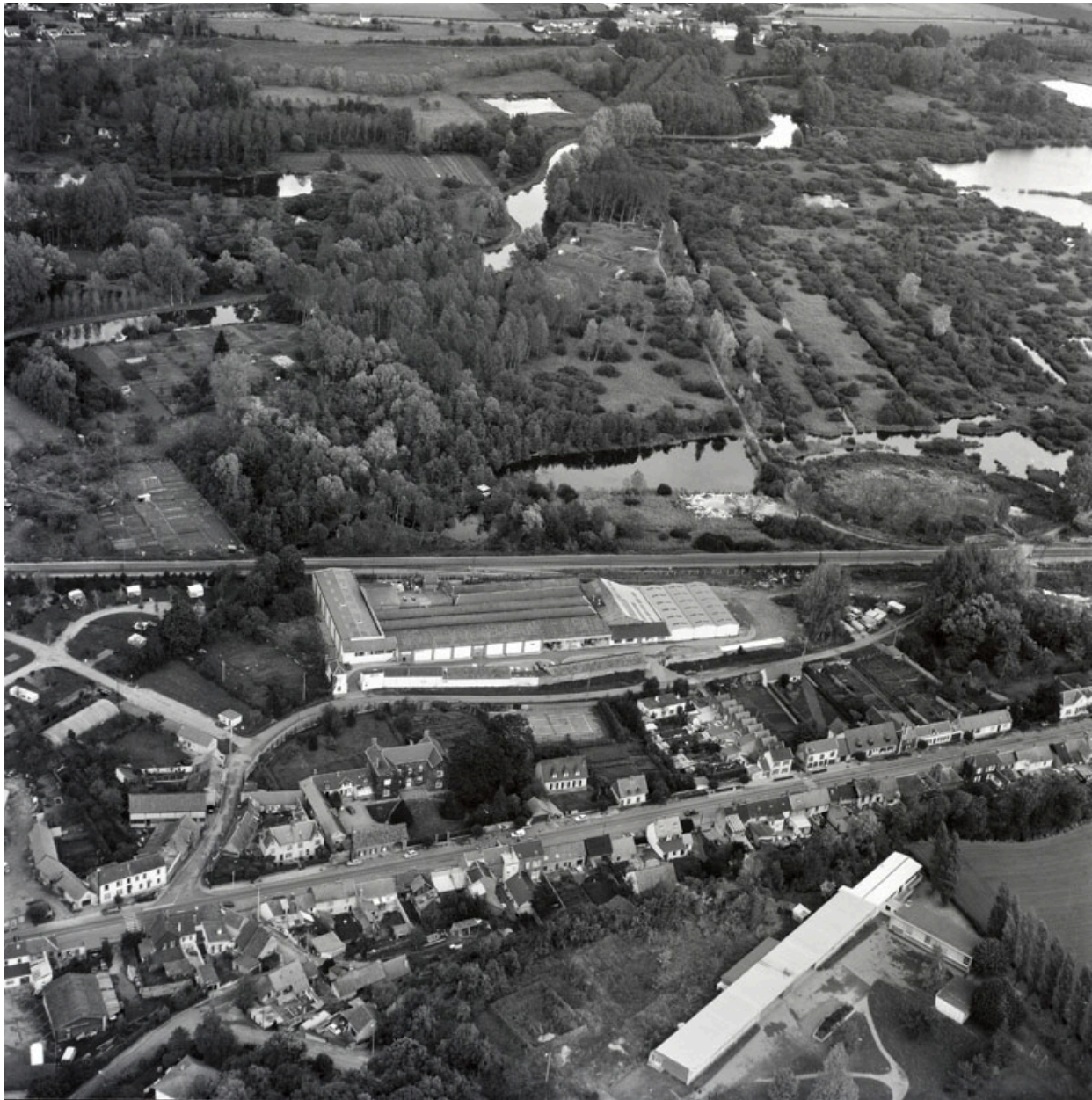
Vue aérienne, flanc sud.
