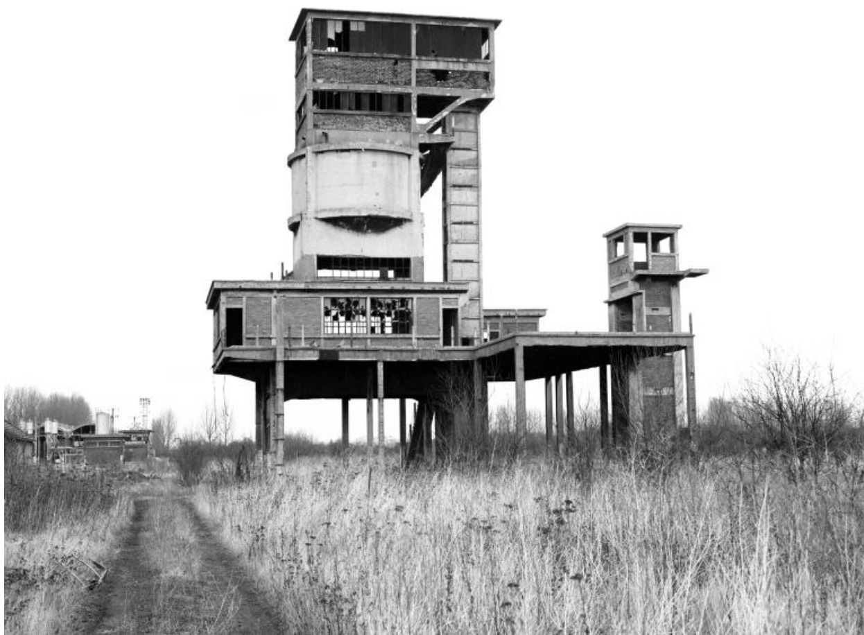
Toboggan à charbon, vue latérale (détruit).
