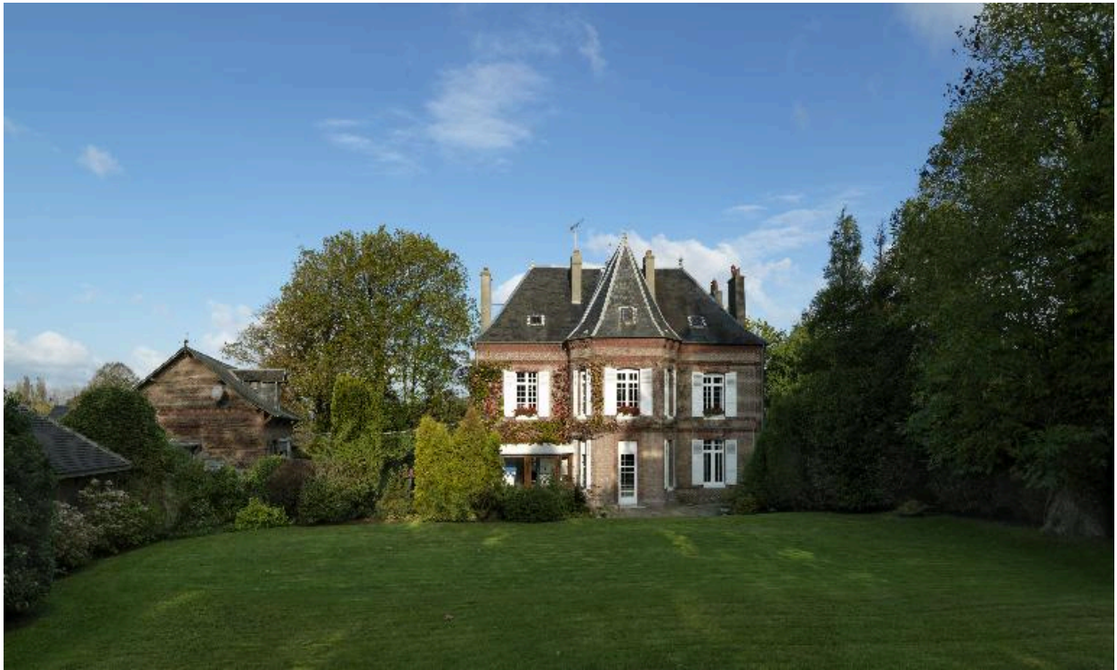
Vue générale de l'arrière de la propriété.
