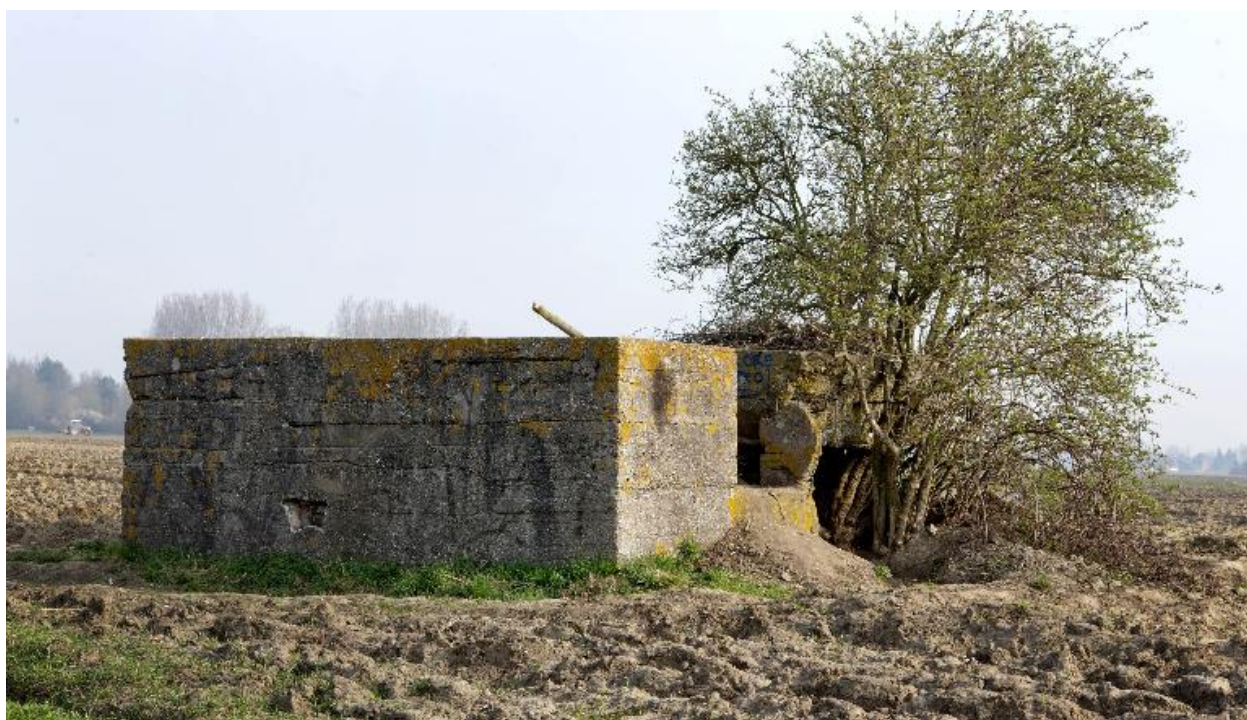
Vue de trois-quarts, vers le nord-est
