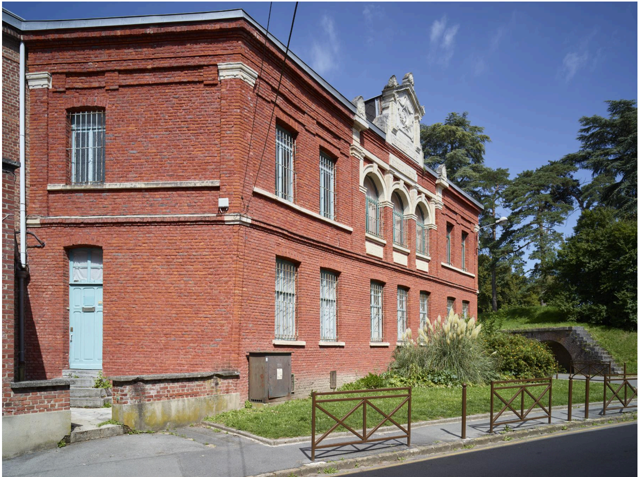
École de garçons : façade principale et façade latérale gauche sur la rue Chevray du bâtiment construit en 1879. Vue orientée nord - sud.
