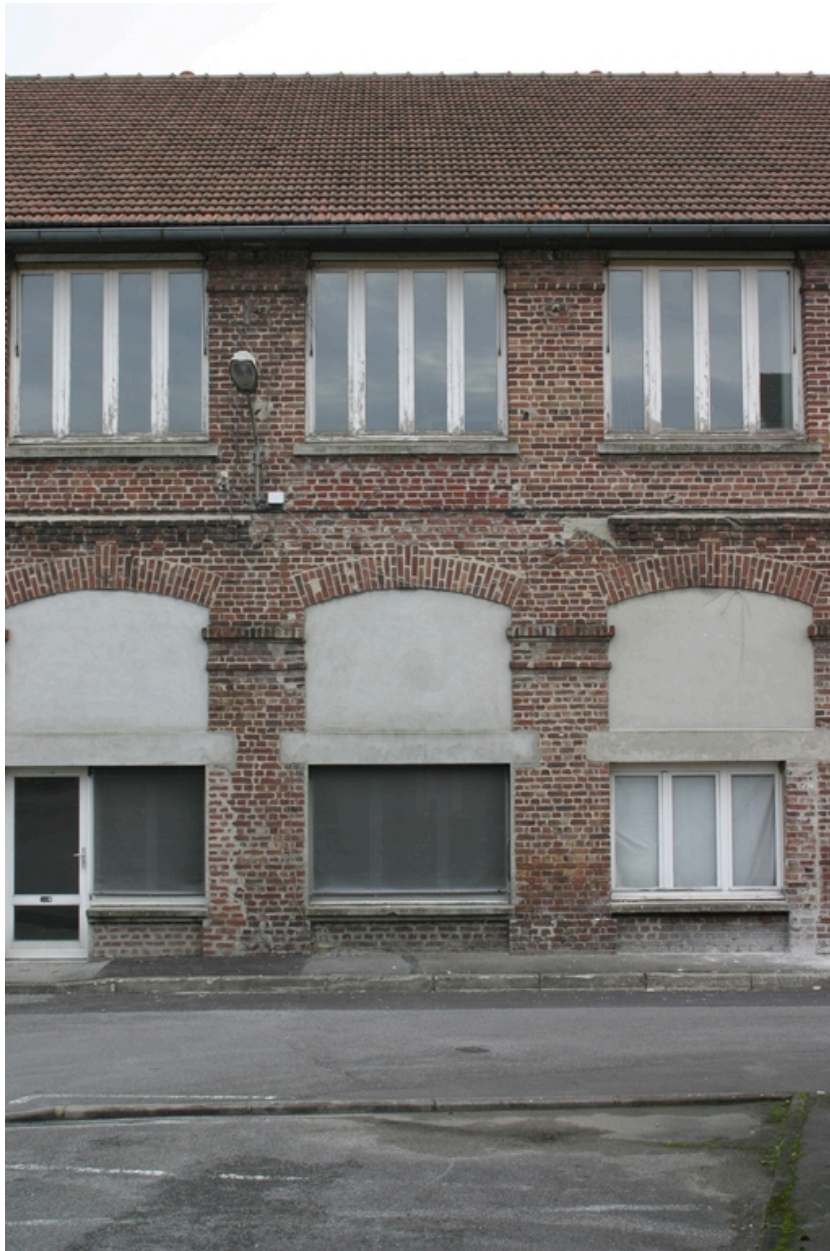
Travée du second atelier de tulle.
