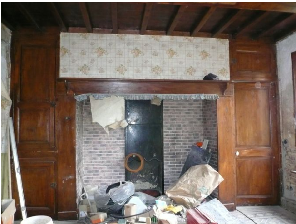
Vue d'une cheminée picarde flanquée de part et d'autre de placards intégrés et d'une porte donnant accès à la chambre.
