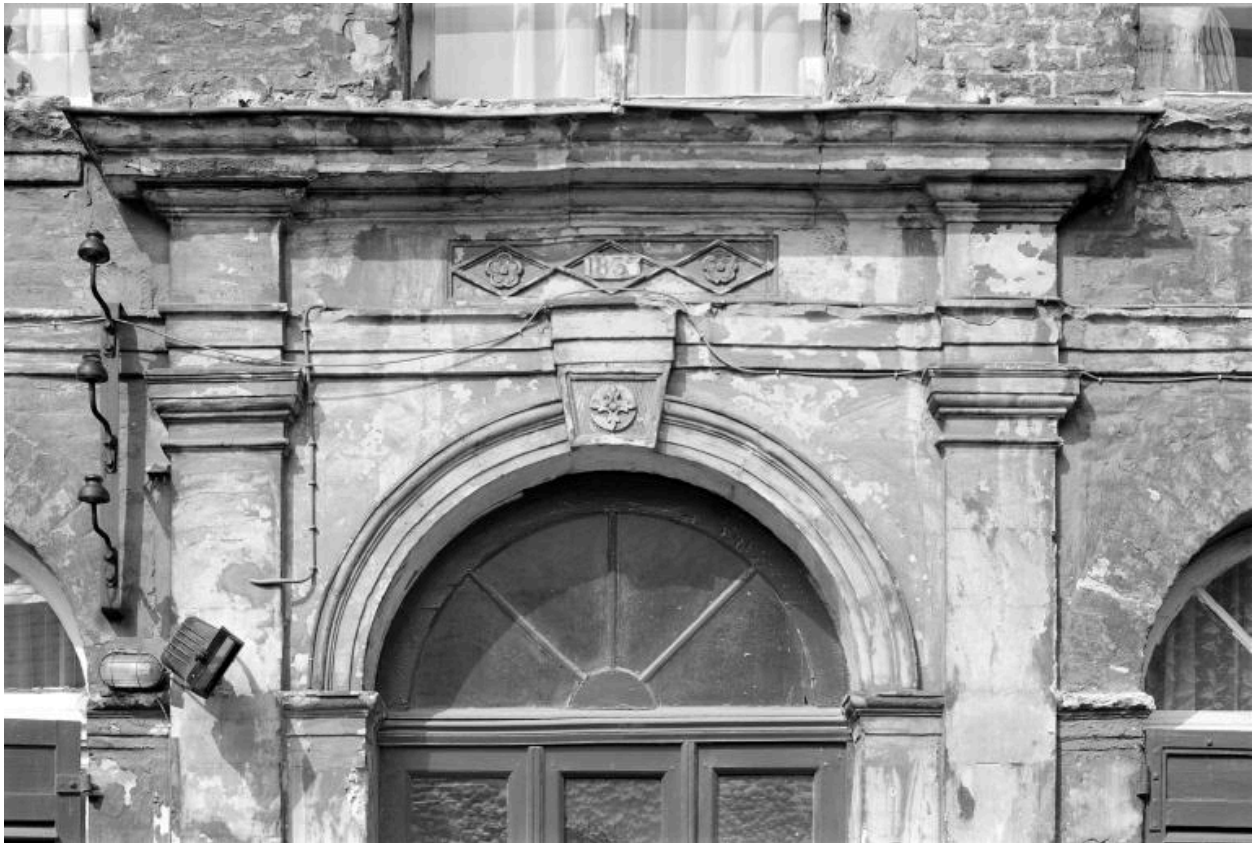
Détail de la partie supérieure de la porte d'entrée du bâtiment principal, portant la date de 1835.
