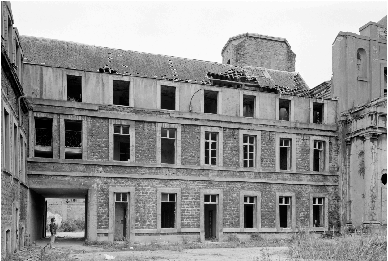
Bâtiment C, partie ouest, façade sur cour.
