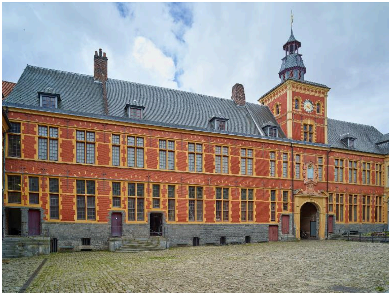
Cour d'honneur, élévation du bâtiment renfermant le passage d'entrée, fermant le côté sud de la cour, vue de trois quarts gauche.
