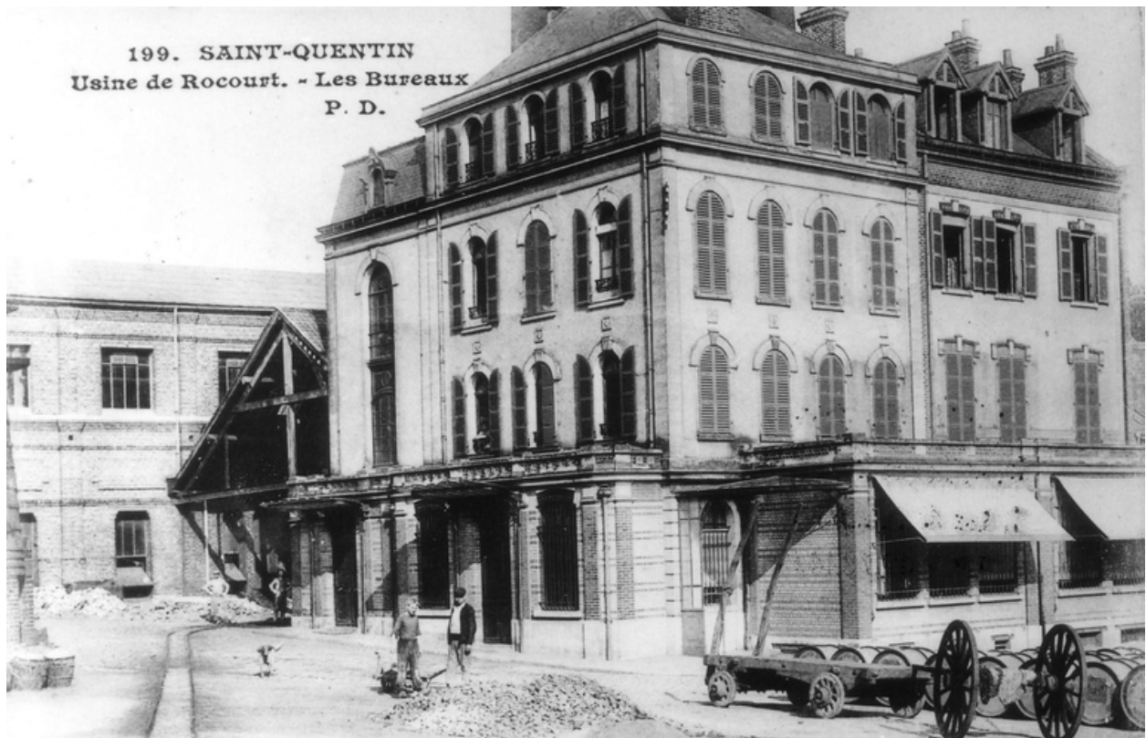
Les bureaux de l'usine, vers 1900 (BM Saint-Quentin).
