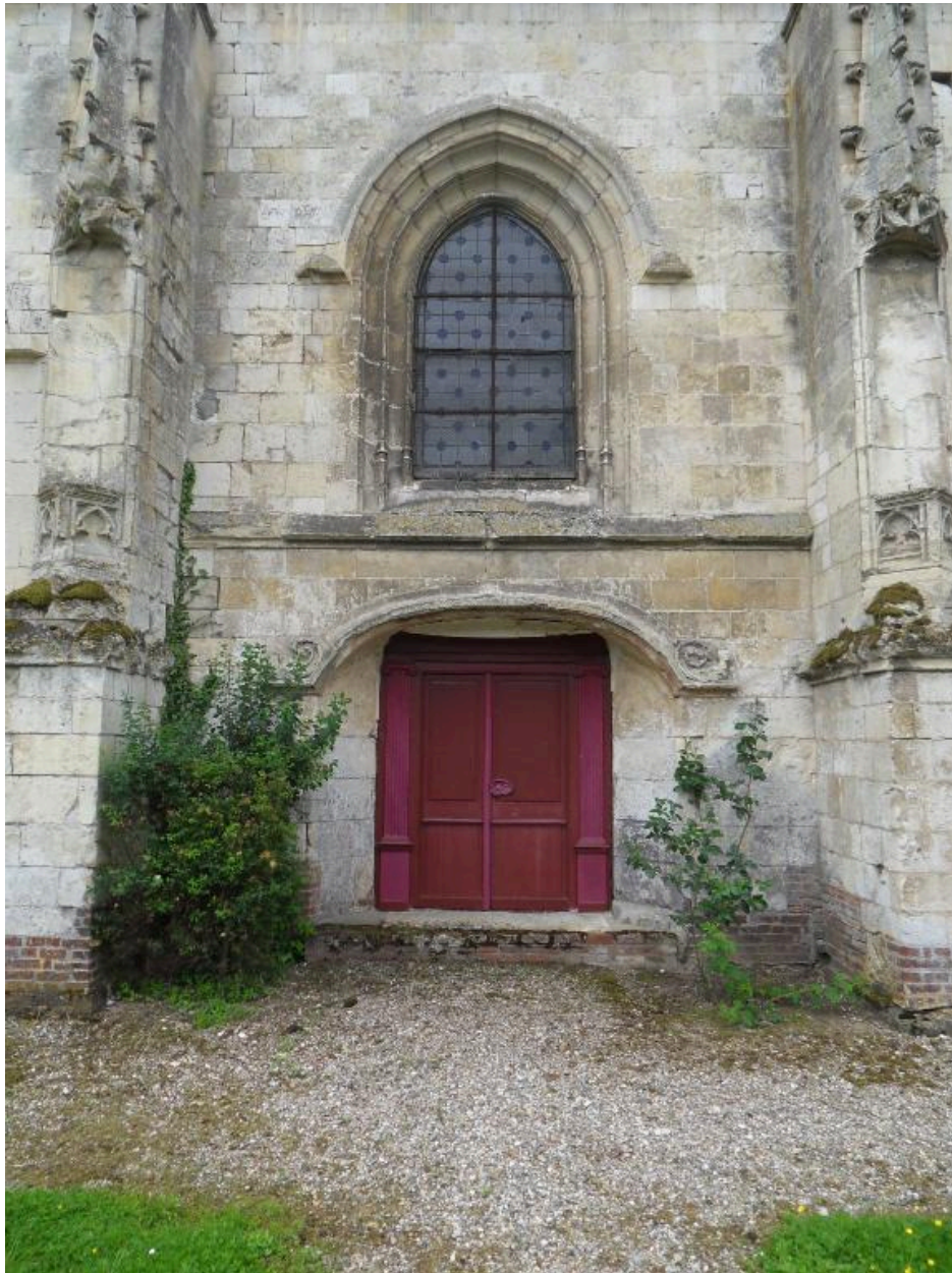
Travée du portail nord
