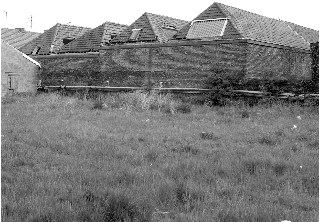
Atelier de fabrication, élévation postérieure.
