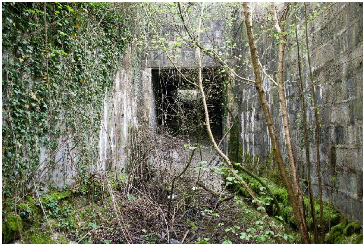
Vue des tunnels. Murs de protection.
