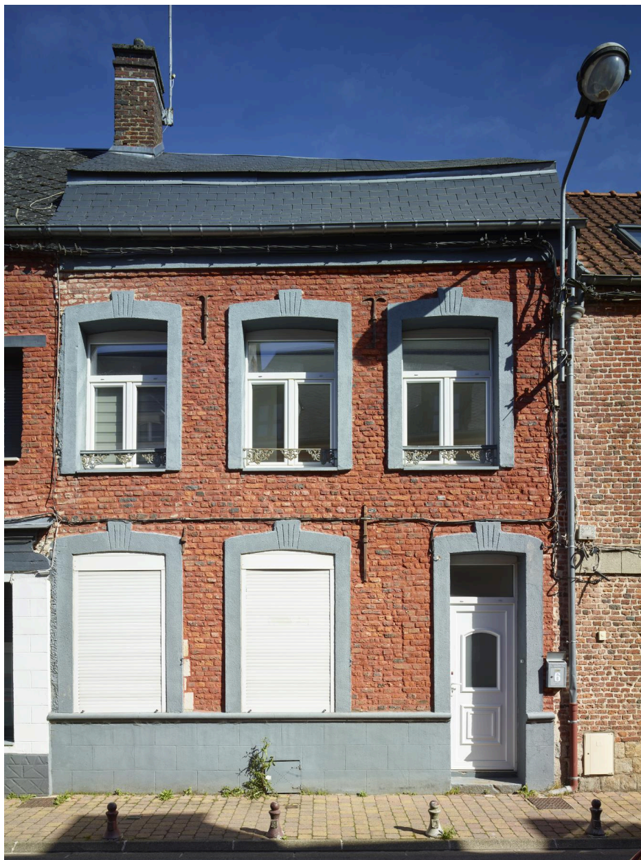
Maison, première moitié du XVIIIe siècle : maçonnerie de briques et fenêtres entourées d'un chambranle à crossette à cru, enduit décoré d'une agrafe et de gouttes, garde-corps tripartites simples avec décor de rinceaux et putti - 6, rue de Strasbourg.
