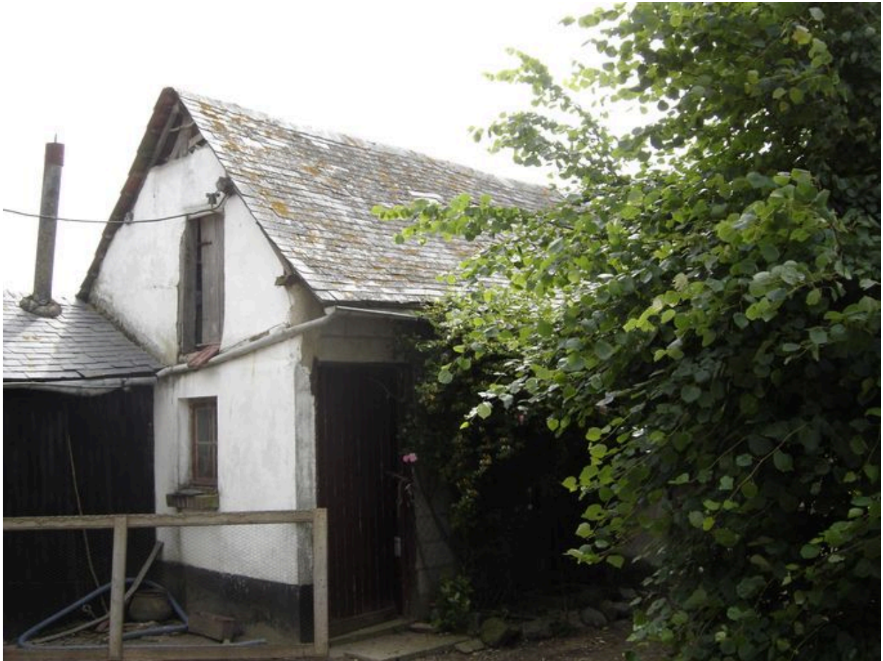
Vue de la laiterie.
