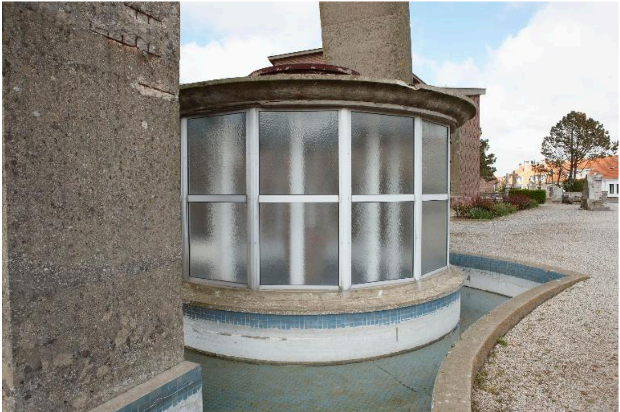
Balcons rue de la Mer ; Henri Valette et Gaston Bellêre architectes.
