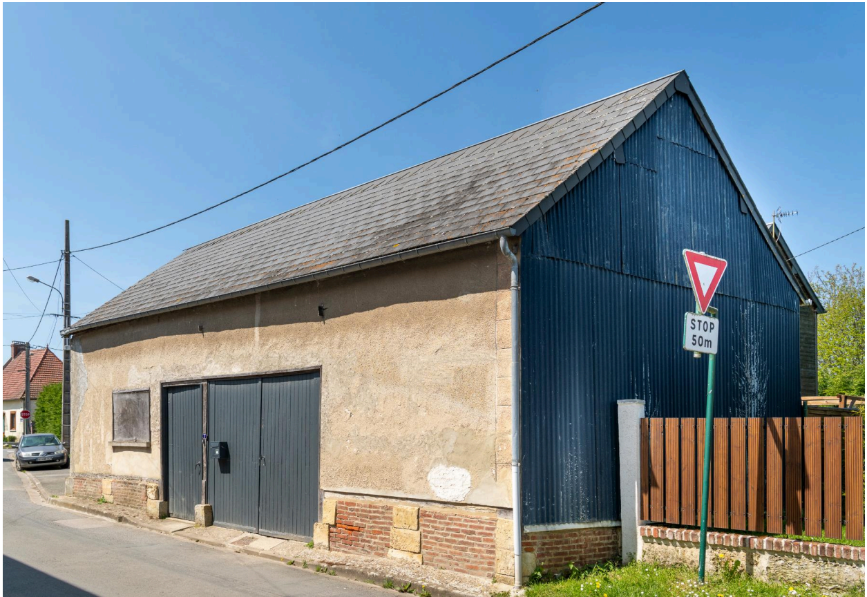
Ancienne maison de serger (?), n°3 rue du Frêne, vue prise depuis le sud.
