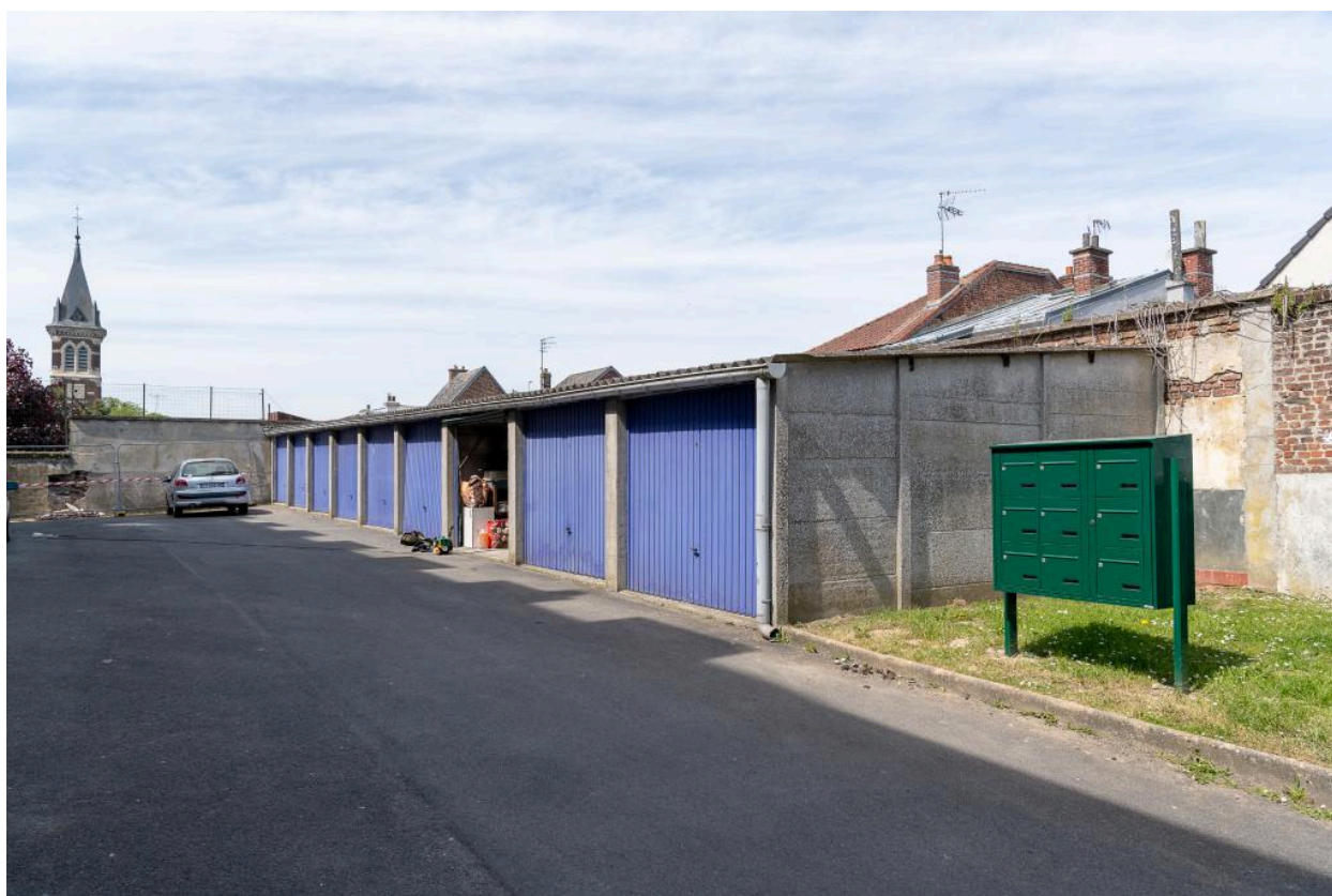
Arrière de la cour : les garages.
