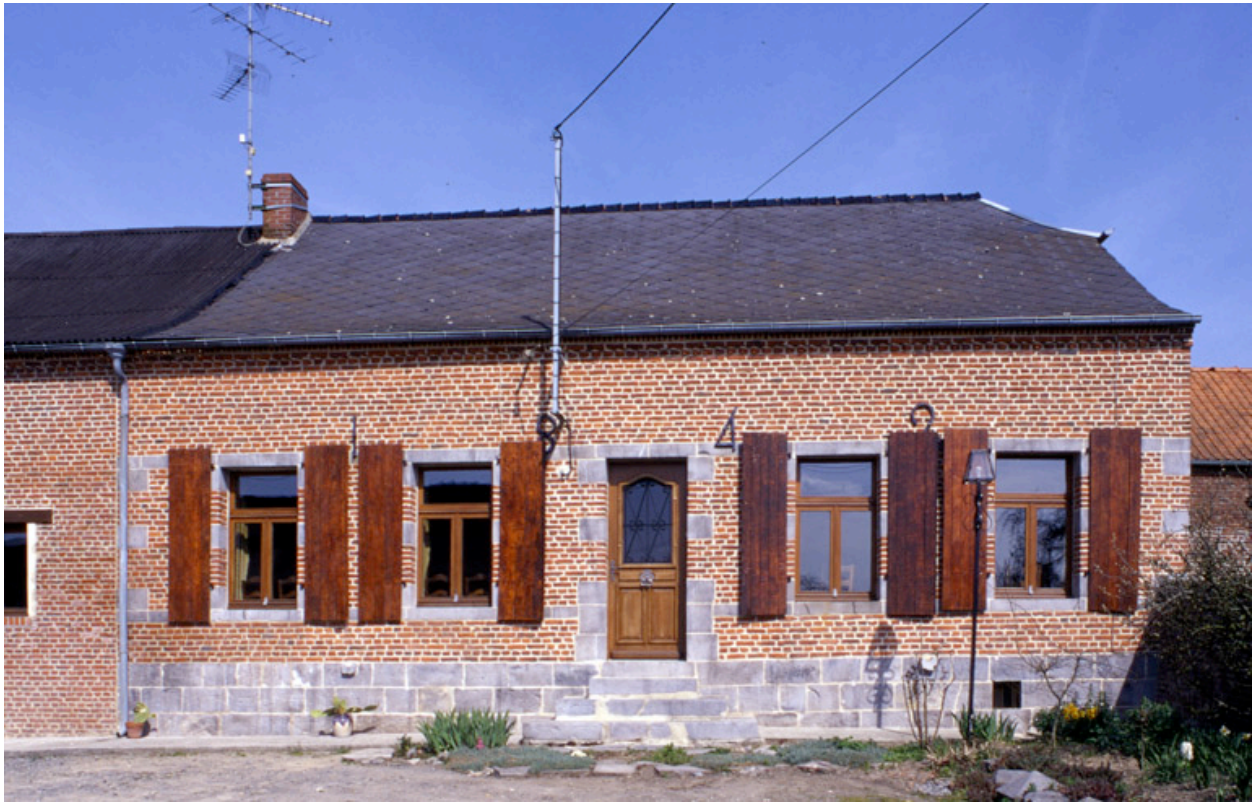
Façade du logis.
