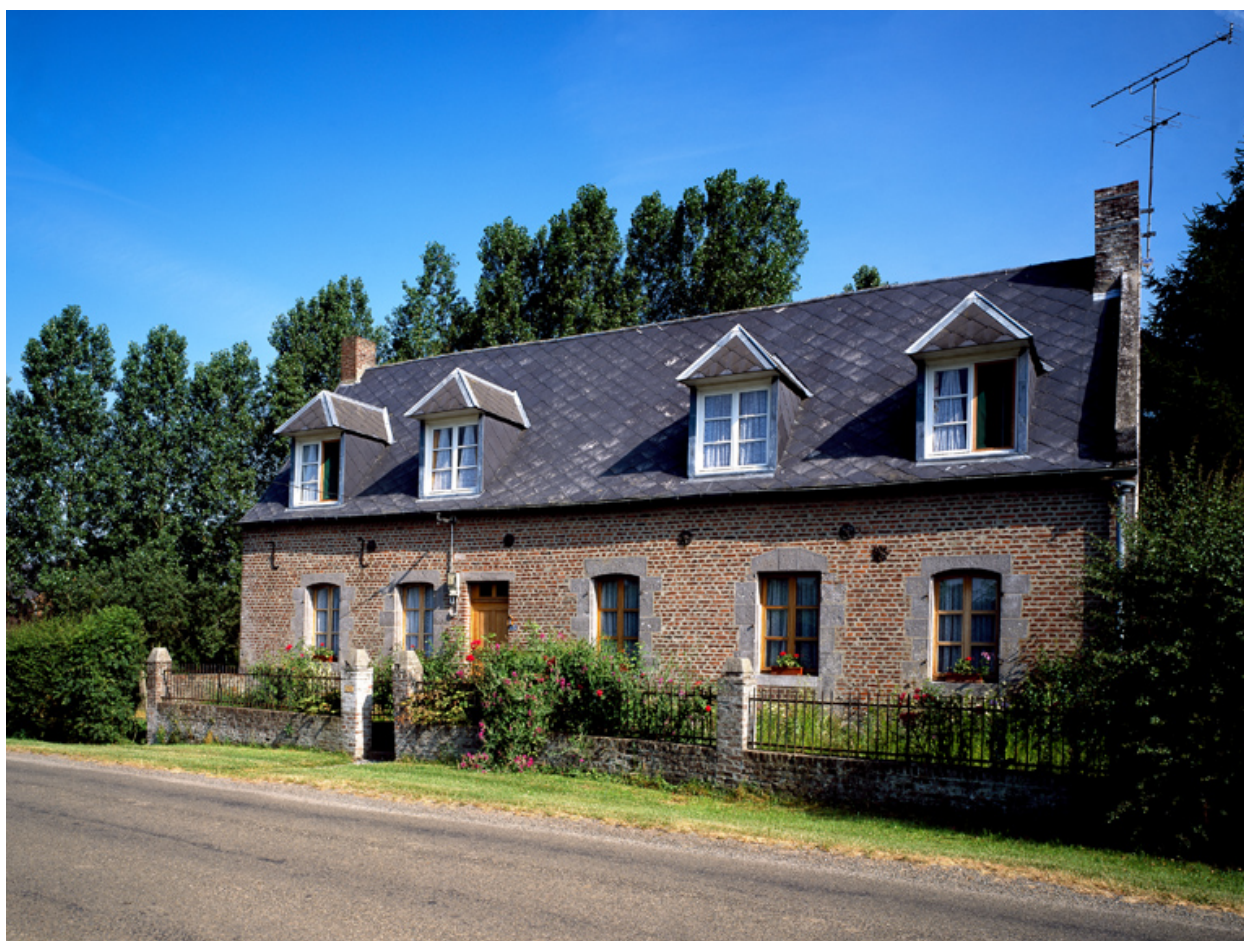
Façade du logis.
