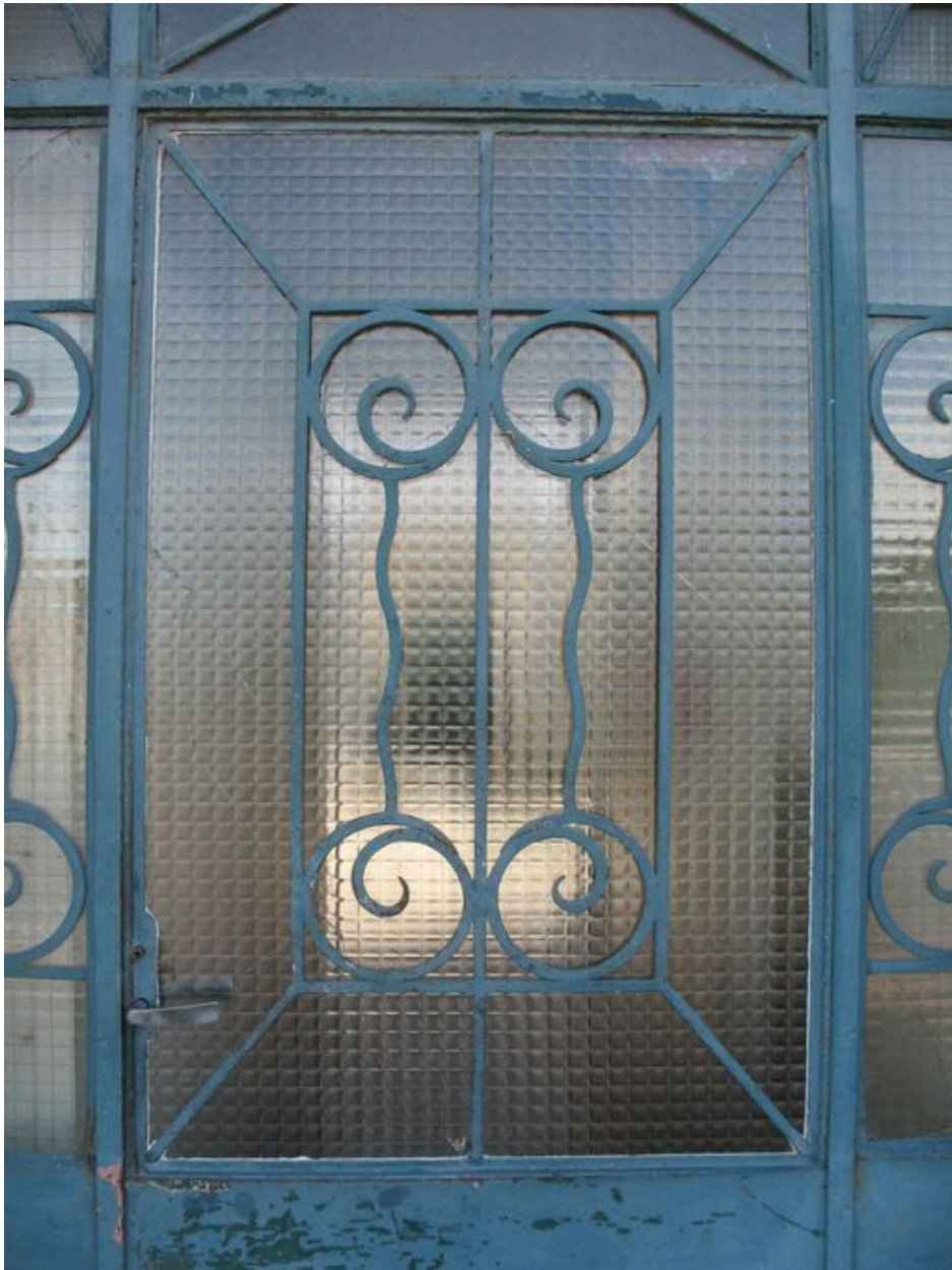
Bâtiment 520 : Détail de la porte d'entrée.
