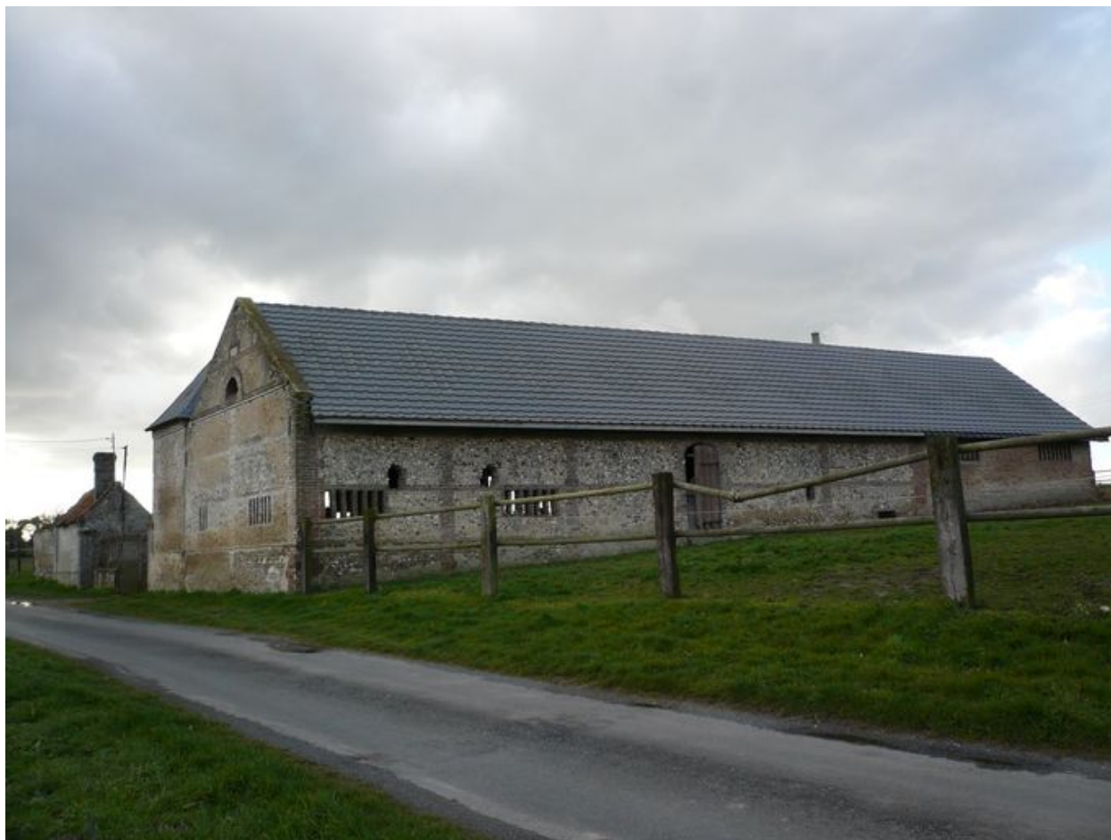
Vue postérieure des dépendances.
