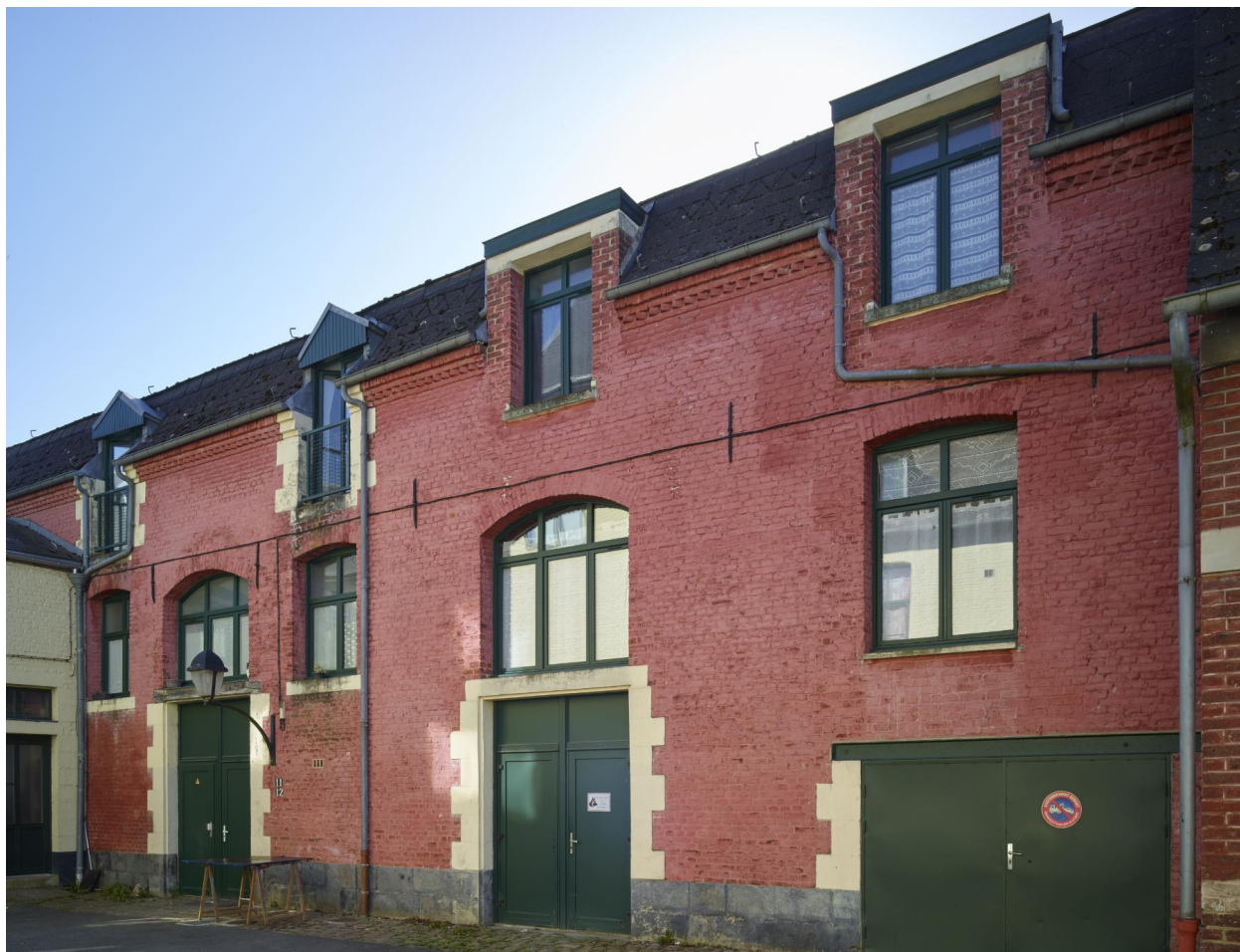
Détail des anciennes écuries, à l'extrémité est de la cour. Vue orientée ouest/est.
