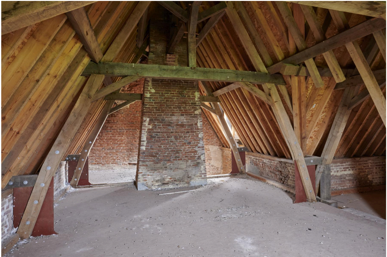
Combles. Logis du XVI e siècle. Conduit de cheminée.
