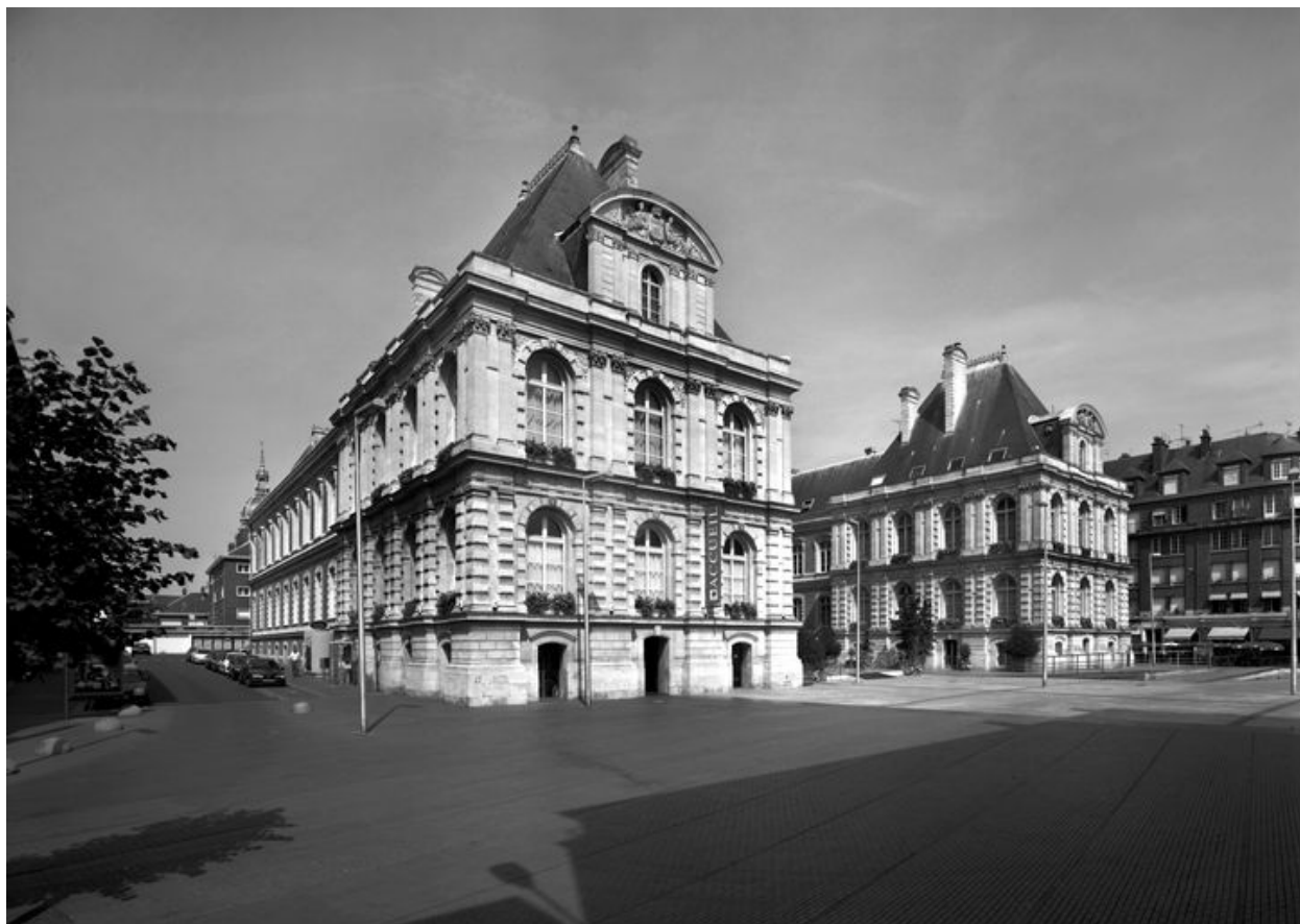
Vue générale, depuis le sud-ouest.
