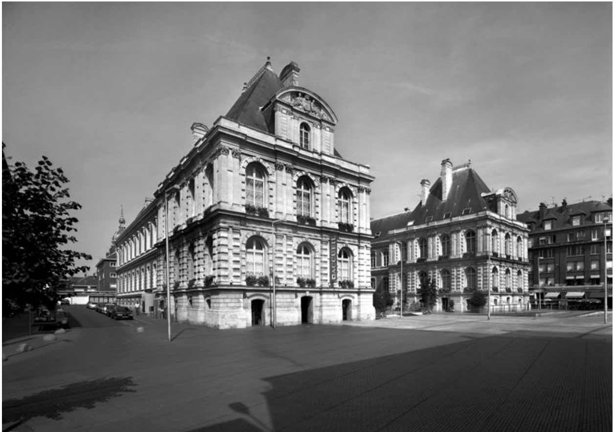
Vue générale, depuis le sud-ouest.
