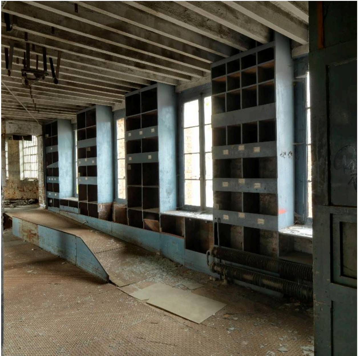
Vue intérieure des anciens magasins.
