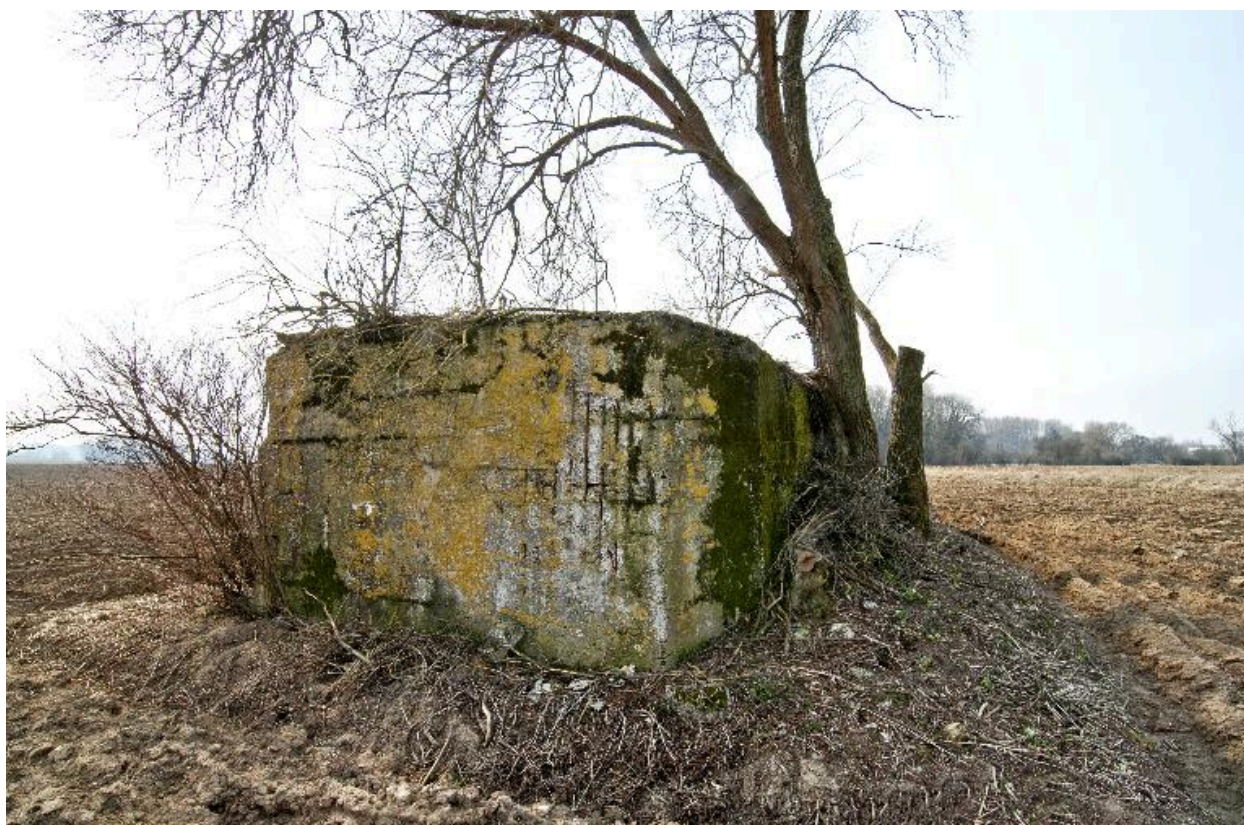
Vue de trois-quarts arrière, vers sud-ouest
