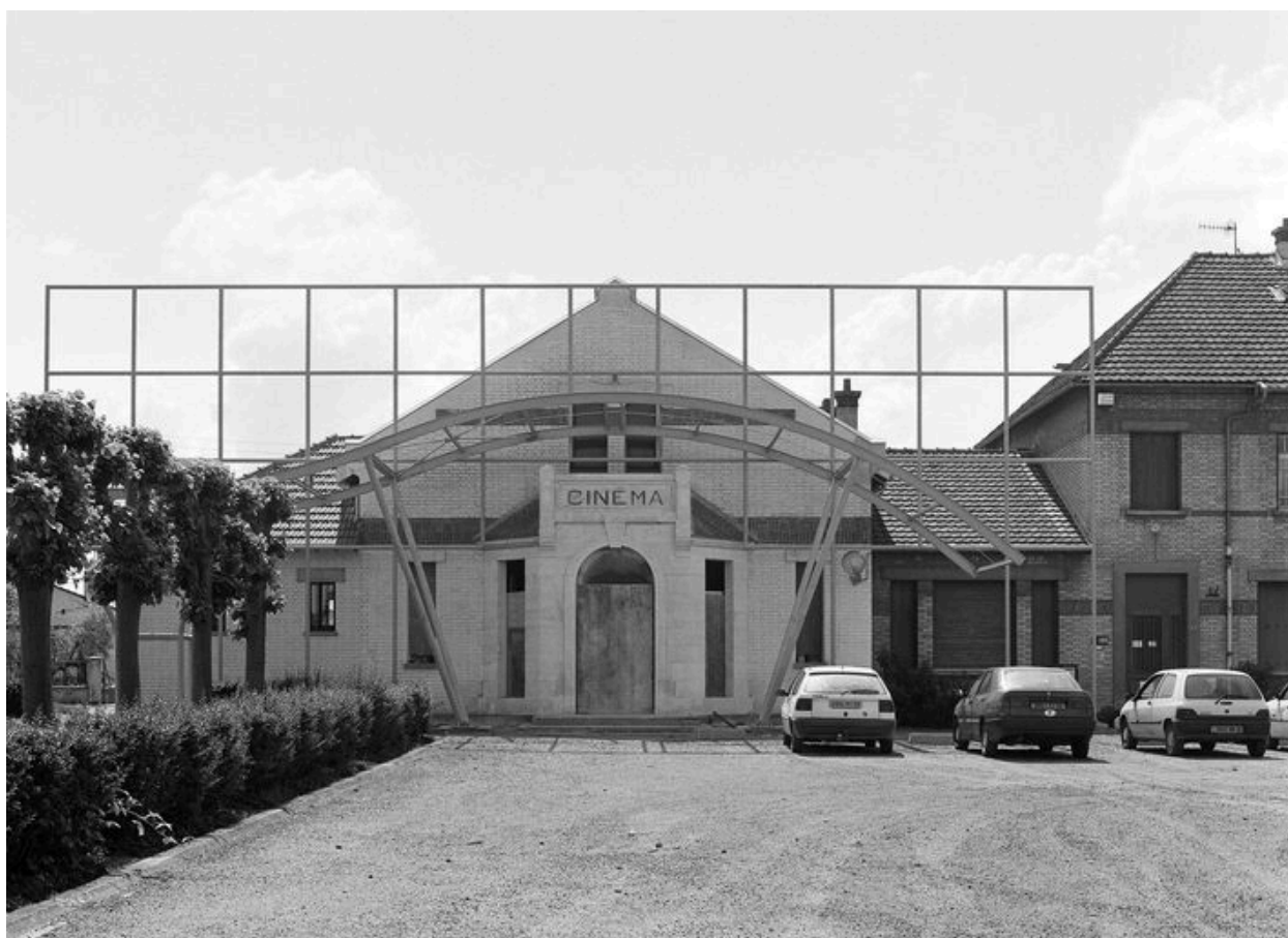
Cinéma : façade principale donnant sur la place.
