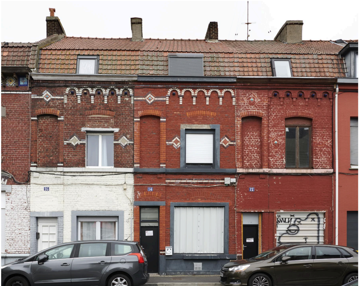
Vue des façades 12-14-16 rue des Ogiers.
