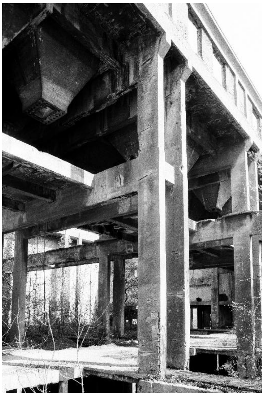
Atelier de fabrication, premier étage.
